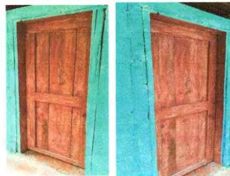
Foto 4: Puertas necesarias, para mayor seguridad
