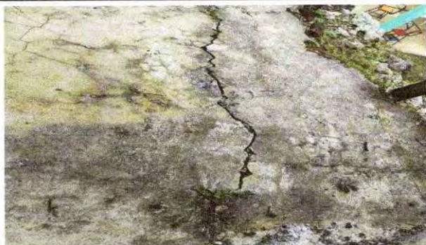
Foto 3: Reparación de piso del salón de clases
