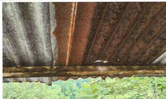
Foto 6: Estructura y techo actual
