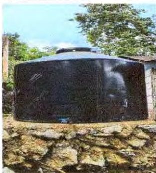
Foto 1: REPARACION Y MANTENIMIENTO DE DEPÓSITO DE AGUA
