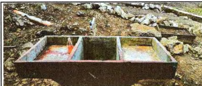
Foto 2: Mejoramiento de red de agua entubada
